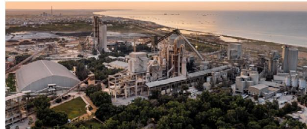
**3 carrières et 4 lignes de cuisson** d'une capacité de production équivalente à **7 000 000 de tonnes** de ciments par an.
