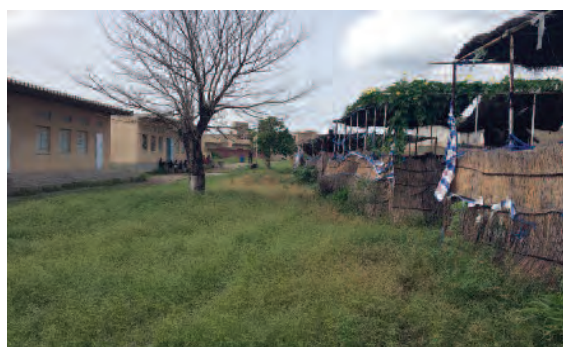
Les abris provisoires de l'école Kip de Bargny avant les travaux
